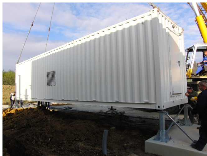
Konténer telepítése Kerkán
