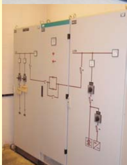
Redundáns alállomási egyenáramú elosztók
