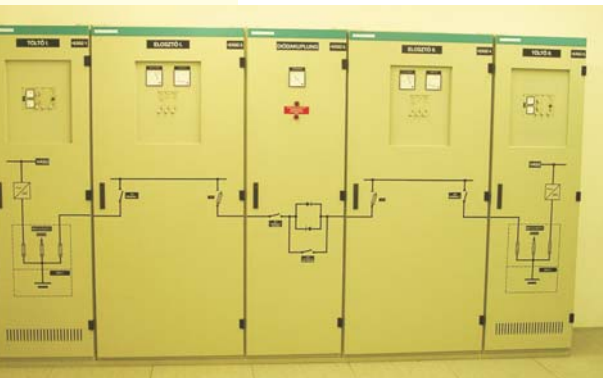
Teljes alállomási redundáns egyenáramú rendszer
