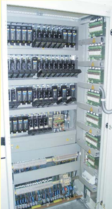
Egyenáramú elosztó szekrény felügyeleti egységekkel
